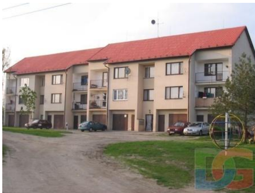
Nová výstavba v obci
